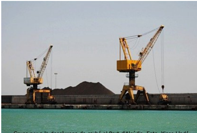
Grues per a la descàrrega de carbó al Port d'Alcúdia. Foto. Xisco Lladó.
